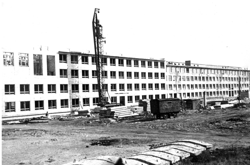
Строительство корпуса А.
