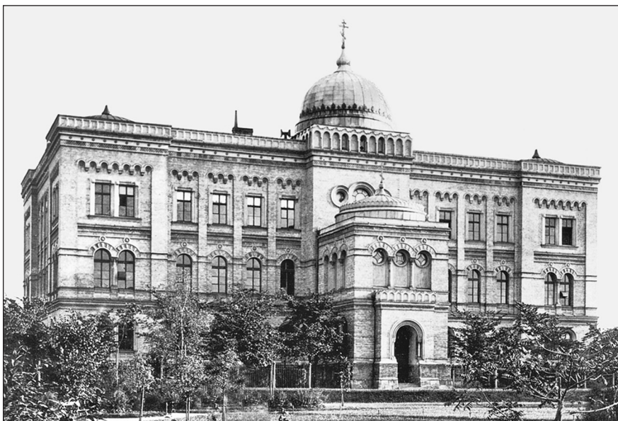
Здание Рижской духовной семинарии в начале XX века. Рига, ул. Пушкинская, 9 (ныне – бульвар Кронвальда, 9). Фото из персонального архива Д. И. Трубецкого
